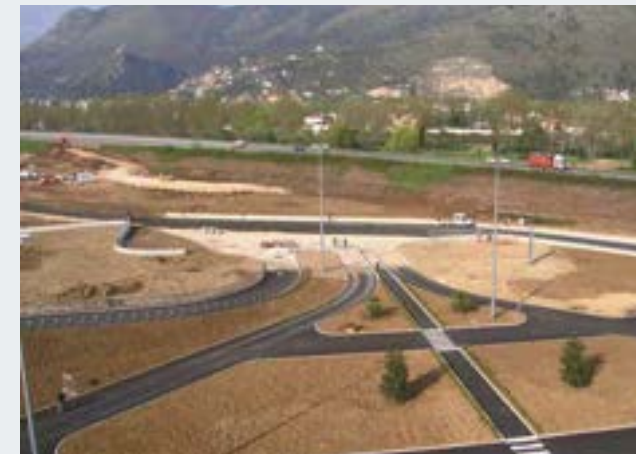
New SSV Sora Interchange | Provincia di Frosinone , Sora, Italy
