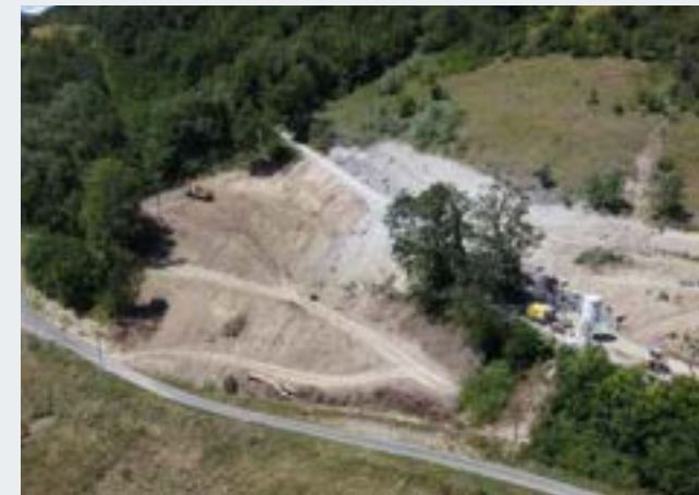
Via Mazzagatti | Comune di Marzabotto Marzabotto, Italy Landslide Emergency - Works Supervision
