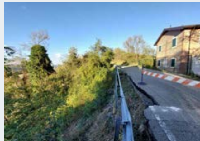
Macroarea #4 | Comune di Pianoro Pianoro, Italy Landslide Emergency - Works Supervision
