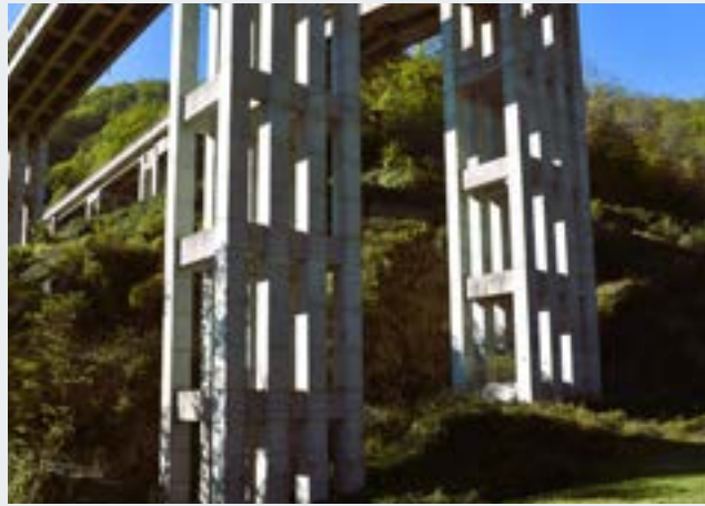
Settefonti Viaduct | Autostrade per l'Italia Barberino del Mugello, Italy Demolition and Reconstruction
