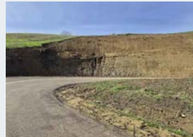
Macroarea #6 | Comune di Pianoro Pianoro, Italy | Landslide Emergency - Works Supervision
