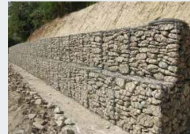
Macroarea #7 | Comune di Pianoro Pianoro, Italy | Landslide Emergency - Works Supervision
